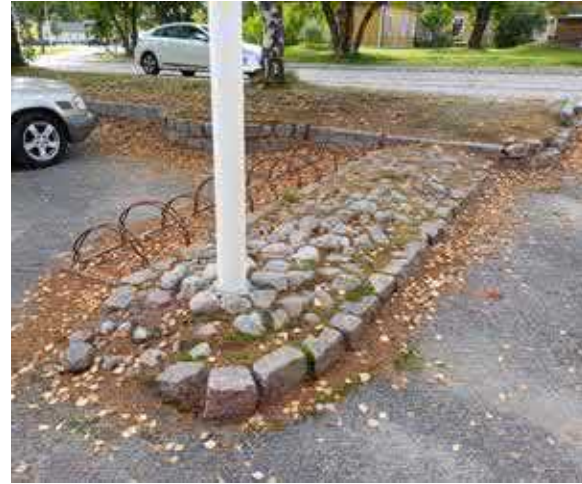
Kuva 30. Radiotalon pihan kiveyssaareke ja ympäröivä asfaltti. Korotettu saareke-ratkaisu ei sovellu alueelle, myös asfaltti on alueelle vieras päällyste.
