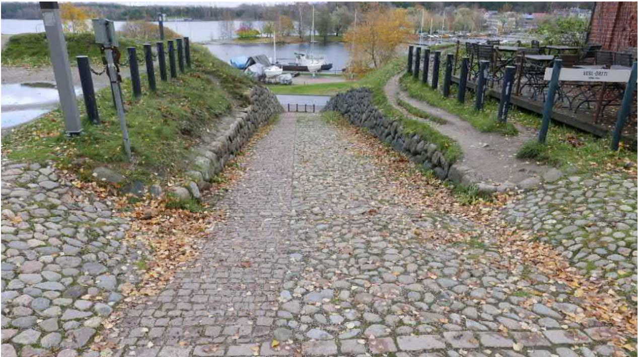
Kuva 112 Vesiportinkuja liittyy Kaupunginlahden rantaan jyrkästi alaspäin laskevaa kujaa pitkin. Kuva Sitowise 2020.
