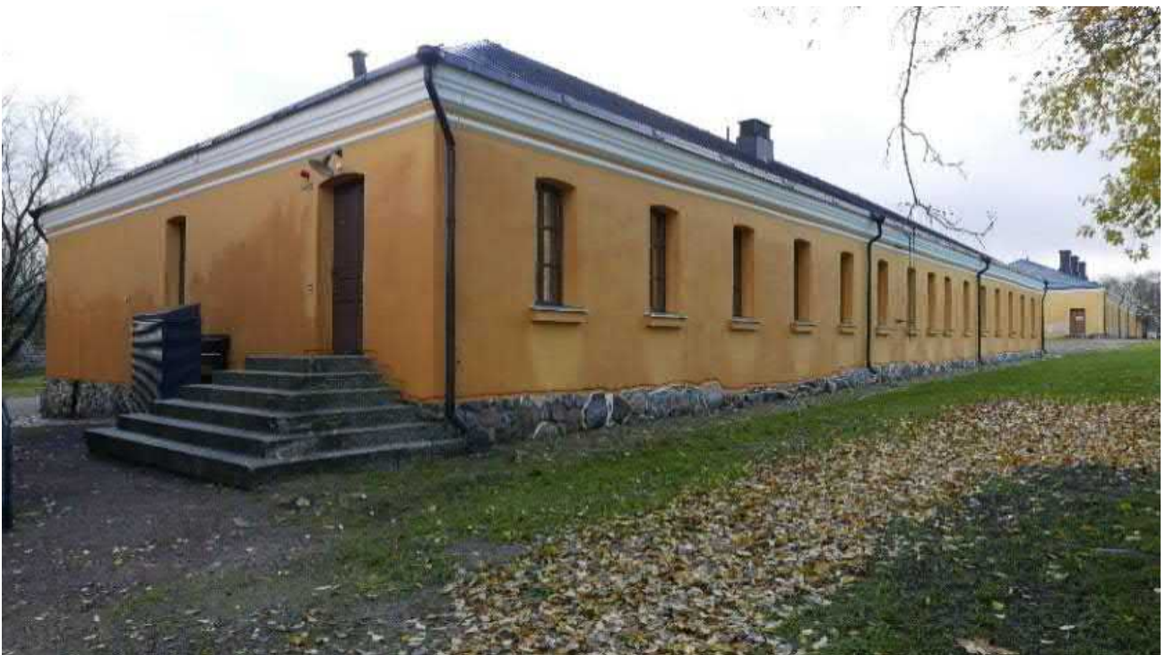
Kuva 116 Kasarmirakennus nro 1b nykyinen kaupunginarkisto pohjoispääty. Taustalla kasarmi nro 1a. Kuva Sitowise 2020.
