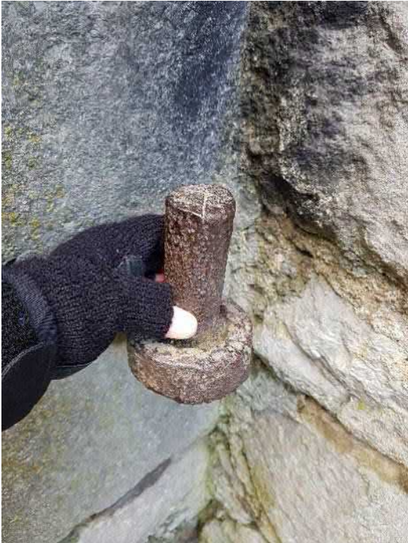
Kuva 111 Portin komero-osassa on säilynyt näyttävät takorautaiset saranatapit. Kuva Sitowise 2020.
