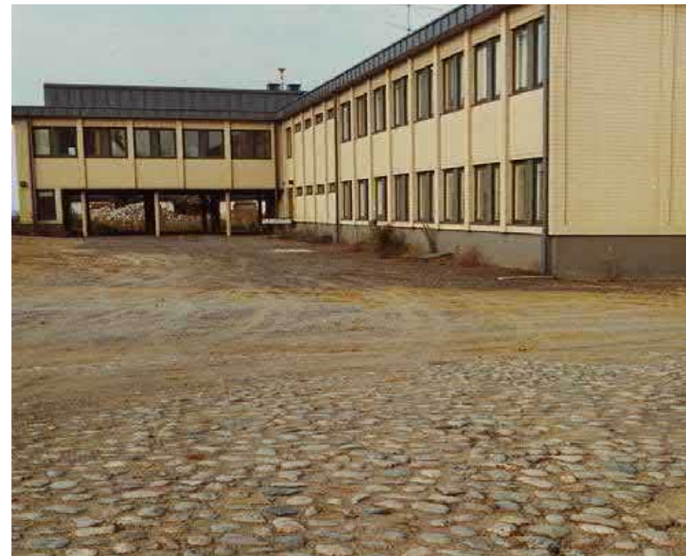
Kuva 33. Radiotalo hieman valmistumisen jälkeen. Rakennuksen edustalla oleva pysäköintialue on sittemmin asfaltoitu. Seuraavien muutos- tai korjaustöiden yhteydessä olisi hyvä poistaa asfaltti ja palauttaa alkuperäinen päällyste.
