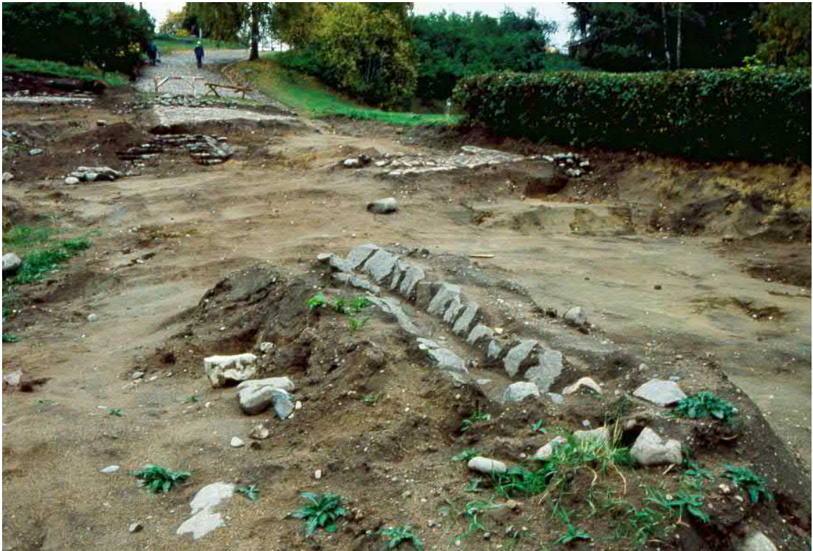
Kuva 12 Lappeenrannan Linnoitus. Länsirinnettä syksyllä 2005 tehtyjen korjaustöiden aikana (Arkeologit kaivausraportti Ulrika Rosendahl, 2005). Kuvaaja Soile Tirilä 2005. Lähde: Museovirasto, finna.fi .
