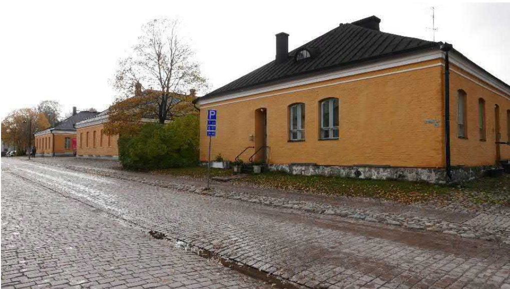
Kuva 126 Erityyppisillä luonnonkivillä toteutettu huolellinen katurakentaminen korostaa hienosti Linnoituksen keskustan historiallista ilmettä. Kuva Sitowise 2020.
