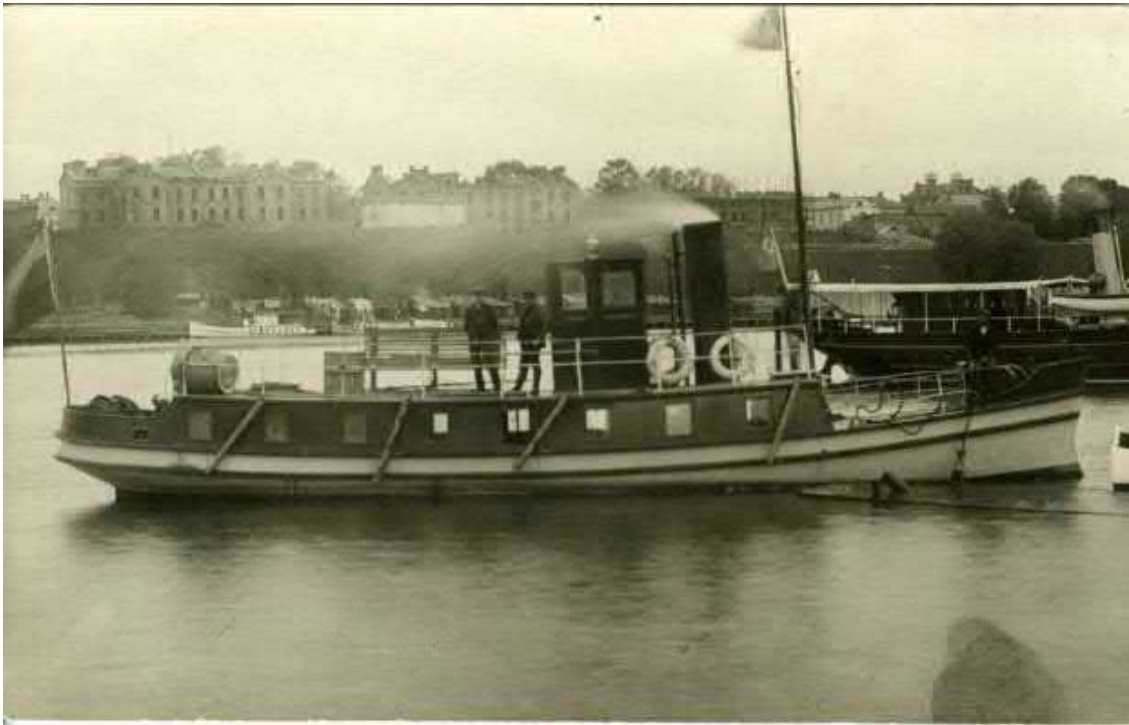
Kuva 60 Lappeenranta höyrylaiva Ahti ja näkymä Kaupunginlahden yli Linnoitukseen. Oikealla tarkastusalus Saimaa, taustalla tiilikasarmien rakennustyö käynnissä. Tunte- maton valokuvaaja 1915. Lähde: Lappeenrannan museot, finna.fi .
