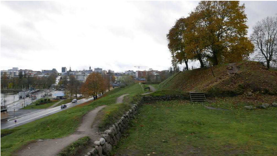
Kuva 143 Näkymä pitkin Linnoituksen itäreunamaa Kipparinkadun suuntaan etelään. Kuva Sitowise 2020.
