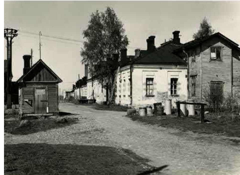
Kuva 32. Kuvassa etualalla mukulakivet ja taustalla sorapintainen käytävä 1970-luvulla. Vasemmalle johtava mukulakivetä käytävä johtaa Haminan portille.
