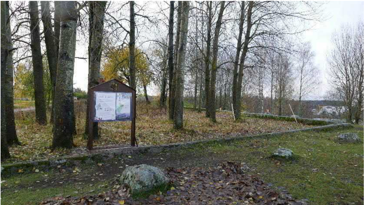
Kuva 121 Pohjois- ja länsivallin yhtymäkohta. Etualalla 1800-luvulla perustetun vankila-alueen muurin rakenteita. Kuva Sitowise 2020.
