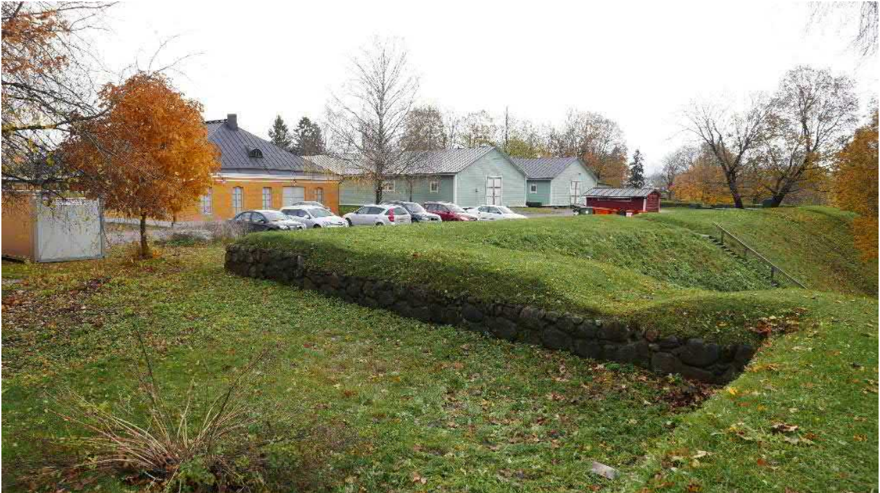
Kuva 142 Länsivalleilta näkymä kasarmeille, nykyinen Lappeenrannan taidemuseo rakennukset nro 23-24 ja taustalla vihreät makasiinit. Kuva Sitowise 2020.
