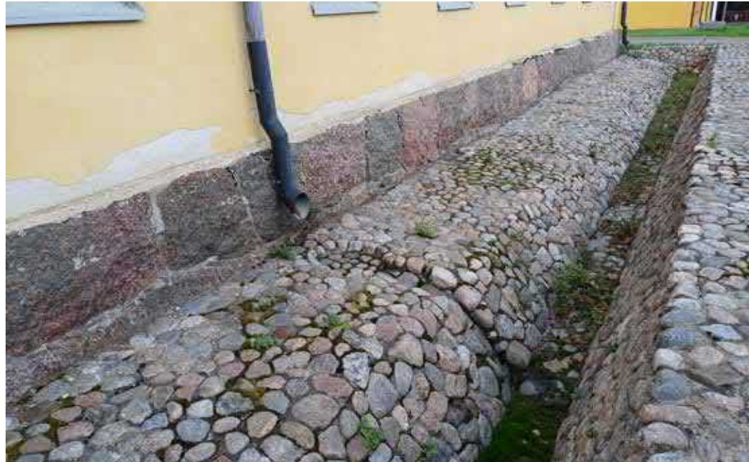
Kuva 41. Mukulakivettyjen rakennuksen seinusta ja hulevesikouru.
