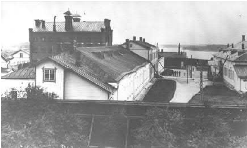
Kuva 34 Lappeenrannan Linnoituksen työvankilan rakennukset lankkuaidan sisällä. Viistokuva alueen sisälle. Takana sellisiipi. Kuvaaja vankeinhoito-osasto, kuvaaja tuntematon 1910-1929. Lähde: Lappeenrannan museot, finna.fi .
