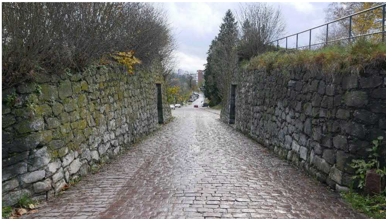
Kuva 109 Kristiinankatu laskee Linnoitusalueelta kapeana muurien välistä kohden kaupunkikeskustaa. Kuva Sitowise. Kuva Sitowise 2020.
