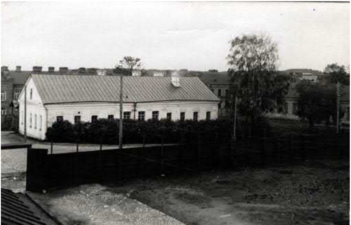
Kuva 68 Lappeen käräjätalo eli Komendantin talo, taustalla 1910-luvun punatiilikasarmit. Käräjätalo kuvattuna rakennus nro 16 katolta. Tuntematon kuvaaja 1928-1938. Lähde: finna.fi , Lappeenrannan museot.
