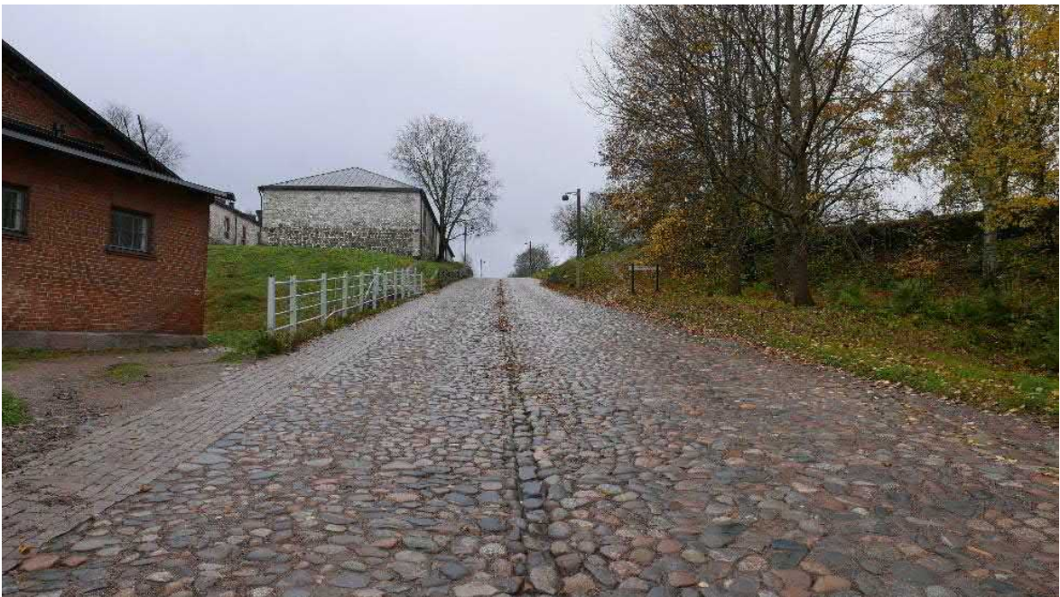
Kuva 114 Savonlinnan portilta Kristiinankatu nousee pohjoisesta saavuttaessa jyrkästi ylöspäin. Kuva Sitowise 2020.
