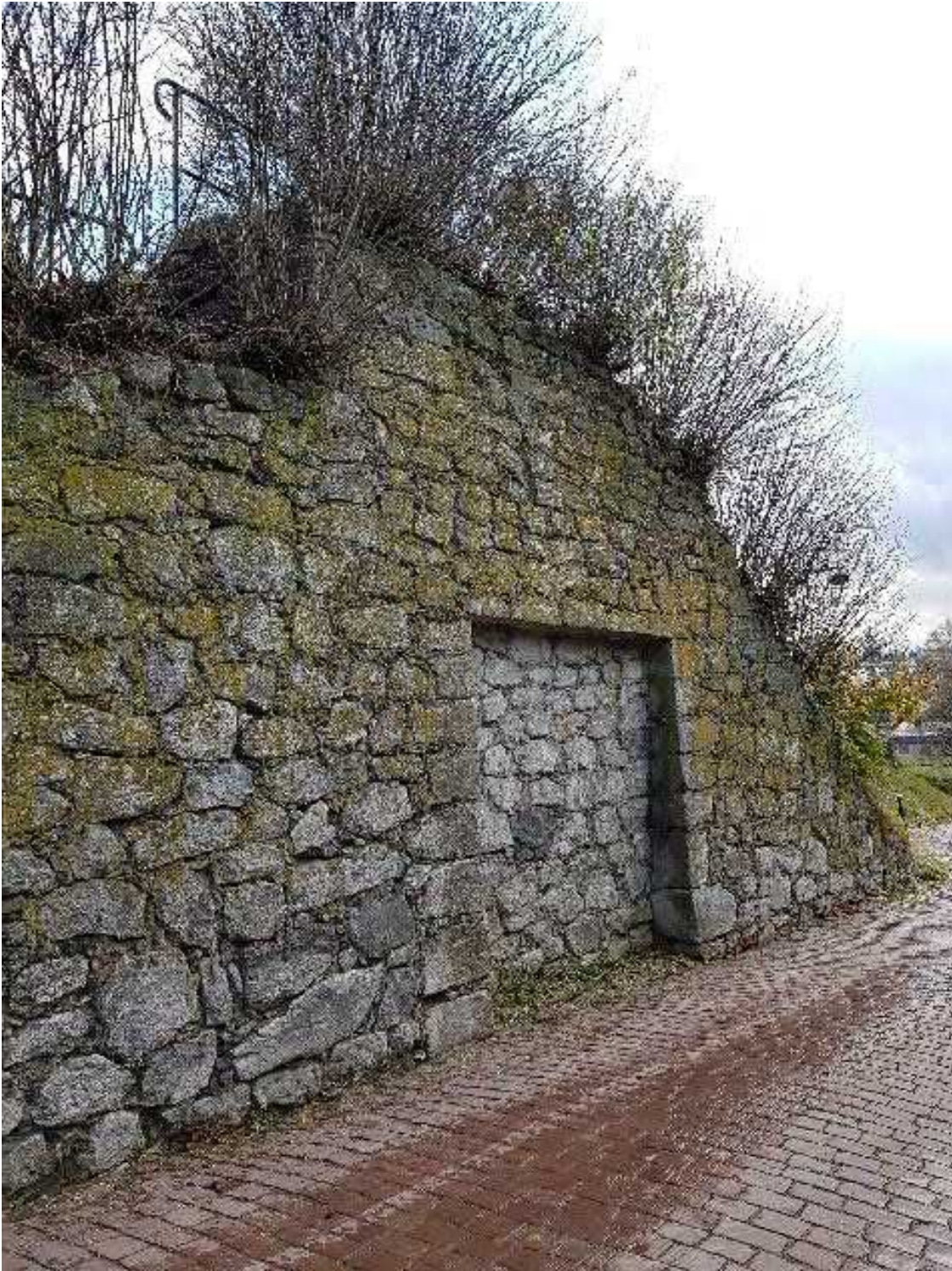
Kuva 110 Viipurin portti lähikuvassa. Portin tukimuurissa on nähtävissä paikallinen vaalea kalkkipitoinen kiviaines, kivien ladonta ja karkea muurauslaasti siteenä, paikoin täyttölaastin tapaan. Kuva Sitowise 2020.
