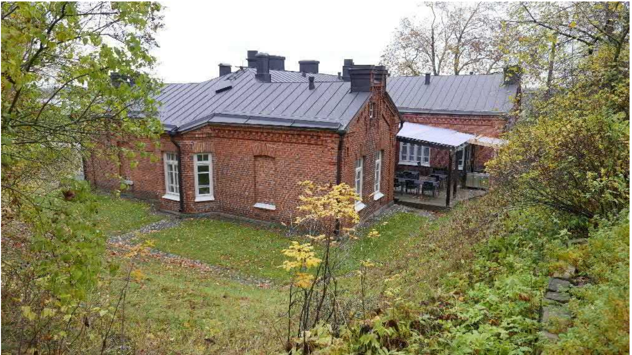
Kuva 149 Itäsivun valleilla oleva suojaisa piha rakennuksen nro 67, eli Linnoituksen Krouvin ja Vesiportin ympäristössä. Kuva Sitowise 2020.
